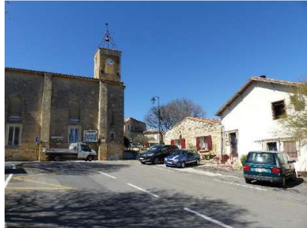
Proximité de la mairie Source : Alpicité, 2023
