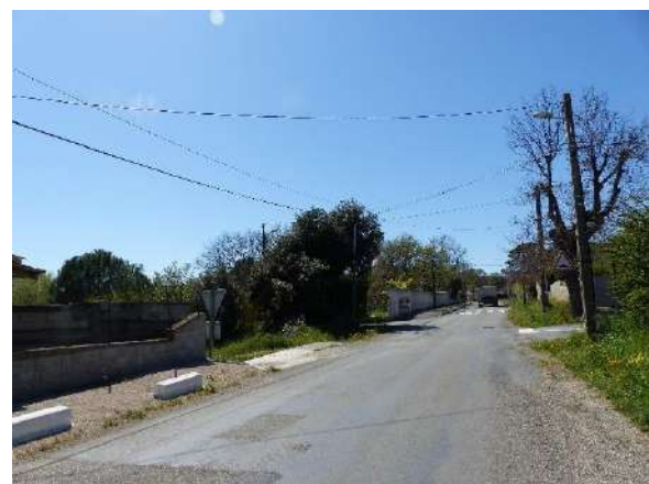
Aménagement piéton le long de la route départementale 221 Source : Alpicité, 2023
