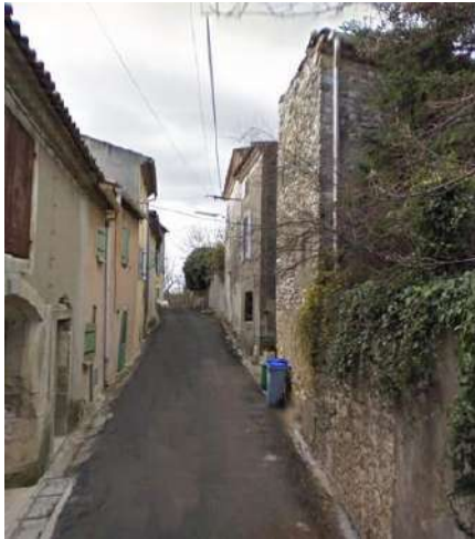
Rue de la Garrigue couverte d'enrobé desservant le bâti vernaculaire du village
