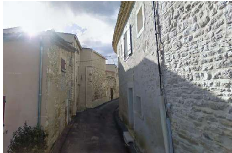
Rue du Puit Neuf desservant un bâti vernaculaire
