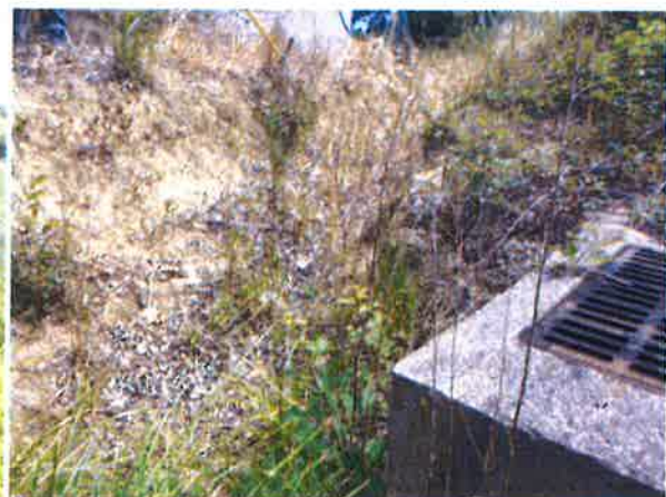
Ouvrage de sortie et seconde surverse
